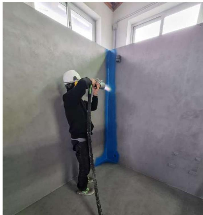
O novo revestimento garantirá uma duração e resistência muito superiores ao sistema anterior, sem sofrer a agressividade química do cloro e provocando assim paralisações da atividade subaquática da Marinha.
